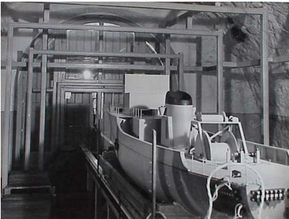
Maquette de bâtiment placée dans le simulateur de champ magnétique du Laboratoire de Magnétisme du Navire localisé sur le polygone scientifique (années 60)
